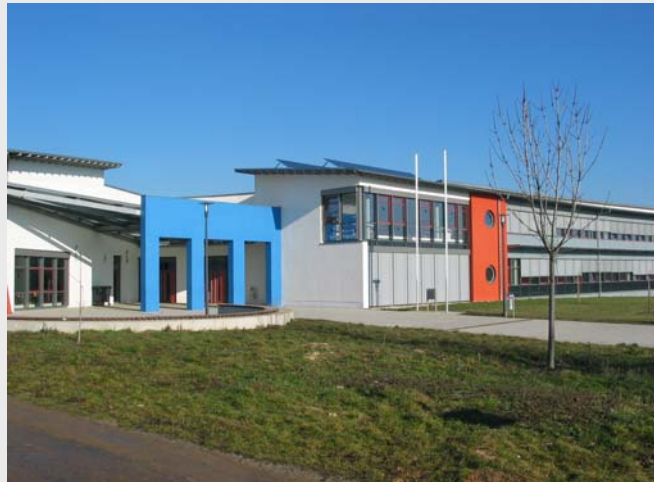
IGS in Stromberg (Architekturbüro Förster & Förster aus Bad Kreuznach)
