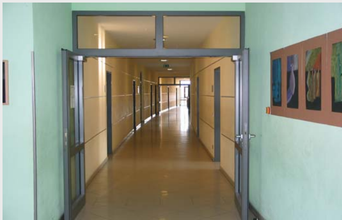
Schallschutztüren mit Doppelfalz und Schattenfugenzarge
